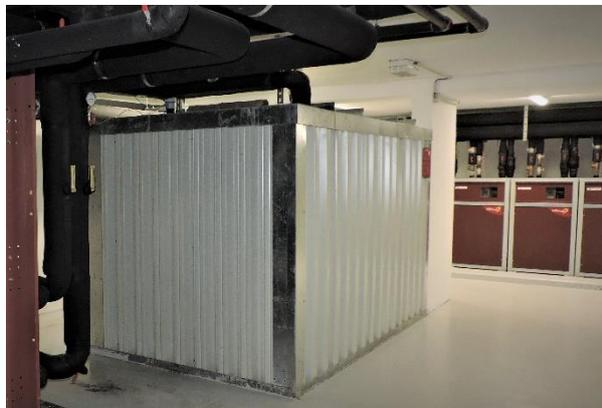
Pour répondre à des appels de froid plus marqués, le système peut également stocker des frigorifiques grâce à un stockage de glace (« Icebat ») utilisant la technologie d'échangeurs Fafco. Cette batterie de froid emmagasine les frigorifiques en période creuse ; puis les restitue en faisant fondre la glace pendant les périodes les plus chaudes de la journée.
